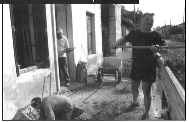
Travaux de la nouvelle bibliothèque
