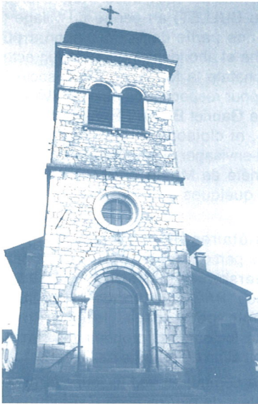
A droite, on aperçoit la nouvelle chaufferie
